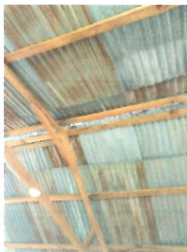
FOTO 1.: CUBIERTA DE LÁMINA. Sustrucción de lámina ondulada por lámina troquelada
