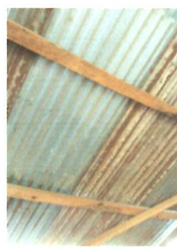
FOTO 2.: ESTRUCTURA DE TECHO.: Sustrucción de estructura de techo de madera por estructura metálica
