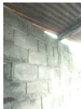
FOTO 4.: REPELLO EN MUROS. Reparación de pared interna en mal estado.
